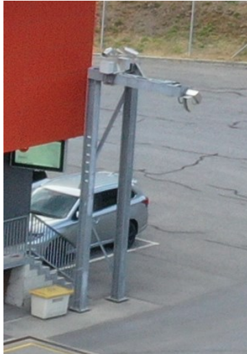
Abb. 6.43 Ausfahrtsportal als Galgen ausgeführt
