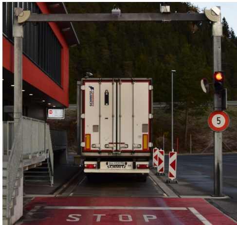
Abb. 6.35 Ampel beifahrerseitig an Portalstütze montiert
