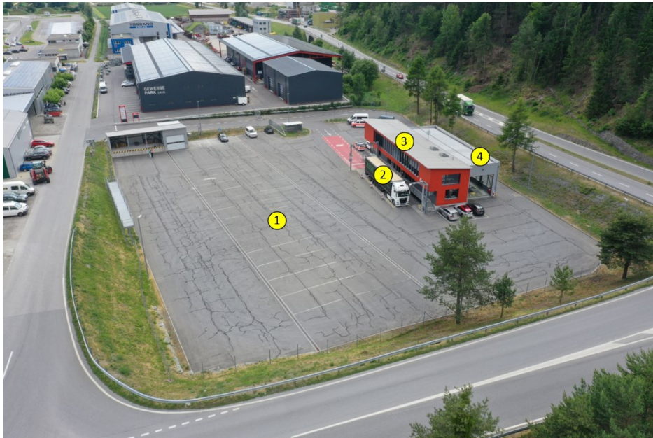
Abb. 2.1 Kontrollplätze (1), Profiler/Waage (2), Bürogebäude (3), Prüfhalle (4)
