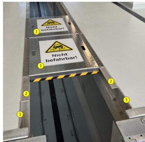
Abb. 6.2 Grubenabschluss und Riffelblech
