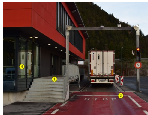
Abb. 6.45 Rampe SVKZ Unterrealta
