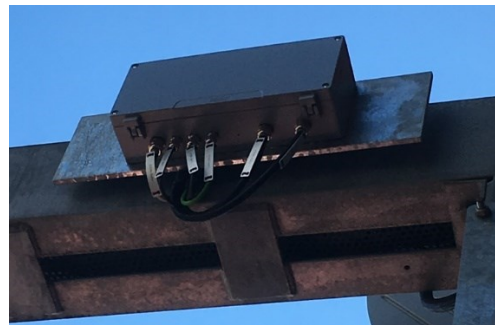
Abb. 6.27 Anschlussbox eines Scanners
